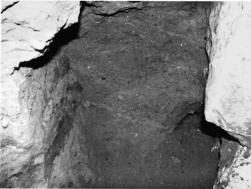
Промежуток между камнями основания столпа (на фото справа) и массивом плотного слоистого грунта засыпан однородным, более сыпучим грунтом с преобладанием песка с примесью мелких камней и углей.
